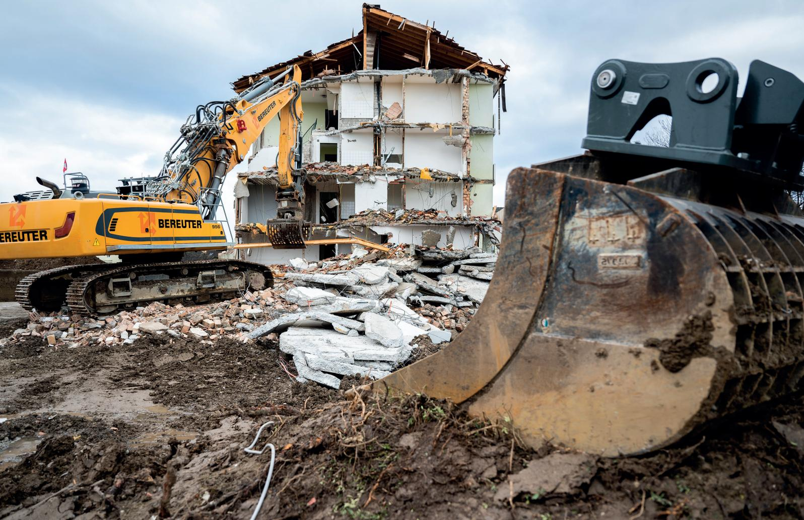
*Beim Rückbau wird das Material feinsäuberlich sortiert, um weitgehendes Recycling zu ermöglichen.*
